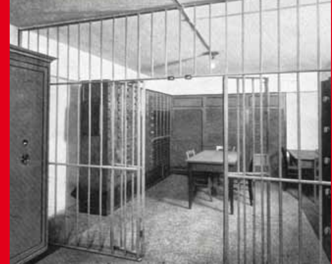
Beim Neubau für die Sparkasse des Kreises Beeskow-Storkow wurde auch ein moderner Tresorraum eingeplant. Die Stahlkammer galt als feuer- und einbruchssicher. (Foto, Ende 1920er Jahre)
