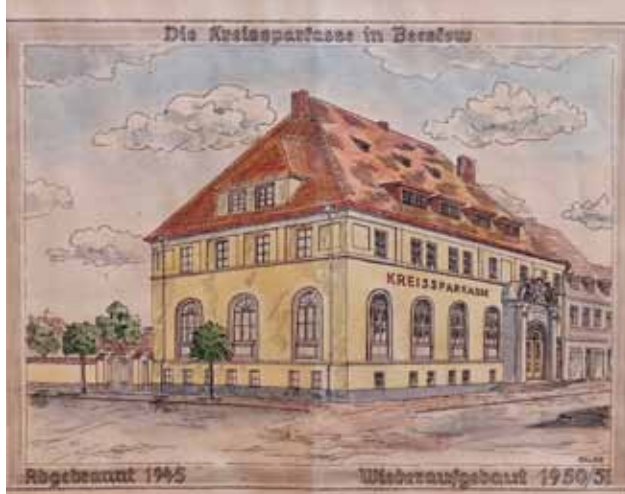
Die 1950 gebildete Kreissparkasse Fürstenwalde beließ den Hauptsitz zunächst noch in Beeskow und zog in das wieder aufgebaute Gebäude an der Berliner Straße. (Zeichnung 1951)
