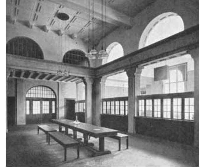
Der Erweiterungsbau des Frankfurter Rathauses an der Großen Oderstraße bot nun der Stadtparkasse die Räumlichkeiten, die aufgrund ihres gewachsenen Geschäftsumfanges dringend nötig geworden waren. Blick in die Kassenhalle zwischen 1913 und 1920.
