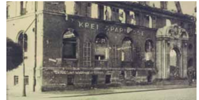
Ein Ergebnis des Krieges: das zerstörte Gebäude der Kreissparkasse zu Beeskow an der Berliner Straße, Aufnahme zwischen 1945 und 1949.
