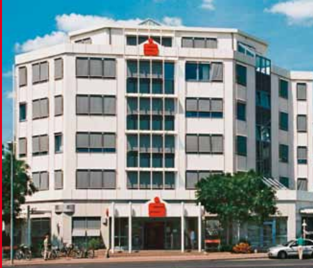
Die Einweihung der neuen Hauptstelle in Eisenhüttenstadt fand am 17. Dezember 1995 mit einem „Tag der offenen Tür“ statt. Eröffnet wurden zunächst nur die Kundenbereiche. Der Innenausbau der Etagen für die internen Bereiche erfolgte bis Anfang 1996. (Foto: Sten Fischer, 2005)
