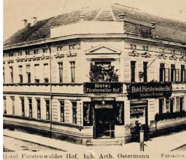
Die Postkarte zeigt das Hotel „Fürstenwalder Hof“, dessen Adresse bis 1920 Promenadenstraße 52 lautete. Mit dem Umzug des Hotels an die Gartenstraße im Jahre 1920 kaufte die Stadt das Gebäude. Es wurde für die Stadtparkasse umgebaut, die 1921 einzog.
