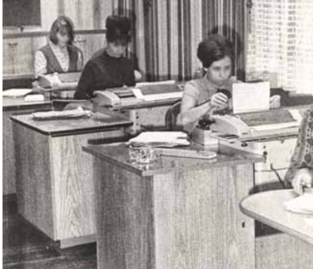
Blick in das Buchungszentrum der Kreissparkasse Fürstenwalde, 1967. Es war in einem schalldichten Raum untergebracht und galt intern als das „Herzstück“ des Betriebes.
