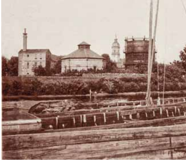
Bereits 1858 baute Fürstenwalde eine Gasanstalt. Theodor Fontane war beeindruckt, dass hier aus Baumstumpen Gas für die Stadlaternen gewonnen wurde. Der Betrieb des Gaswerkes mit weitläufigem Gasrohrnetz und Gasometer wurde auch mit Krediten der Sparkasse finanziert. (Foto, um 1900)
